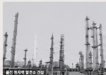
물진 원자력 발전소 건설
