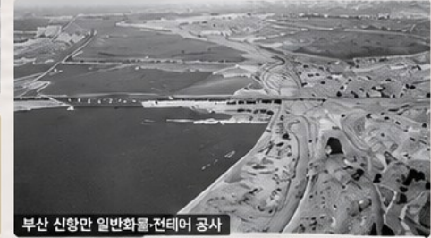
부산 신항만 일반화물-컨테이너 공사
